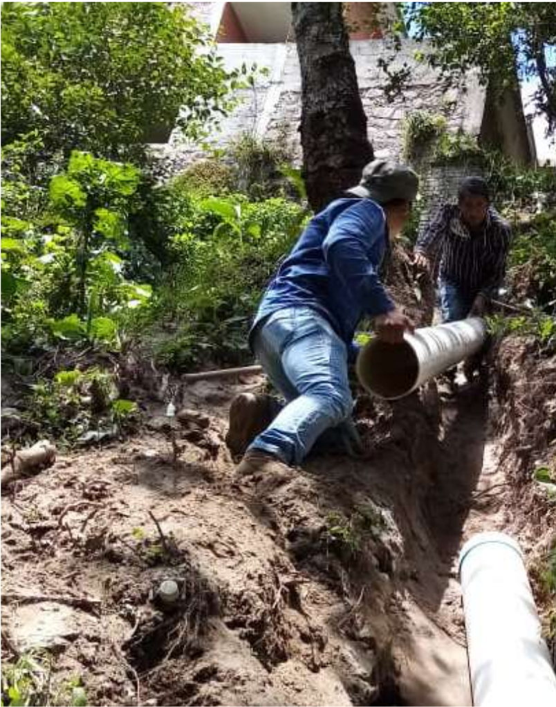
CONSTRUCCIÓN DE NUEVAS LÍNEAS DE AGUA POTABLE: CHIGNAULINGO, XALAME, ATOLUCA Y BARRIO DEL FRESNILLO.
