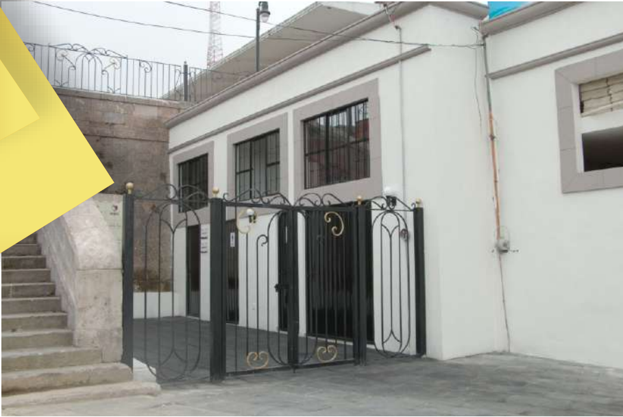
SE CONSTRUYERON LAS OFICINAS DEL INSTITUTO MUNICIPAL DE LA MUJER.
